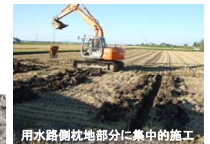
用水路側枕地部分に集中的施工
